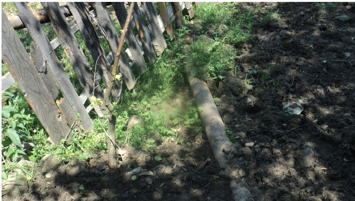
Foto 7 - conducta dezvelita la traversarea drumului de pamant
